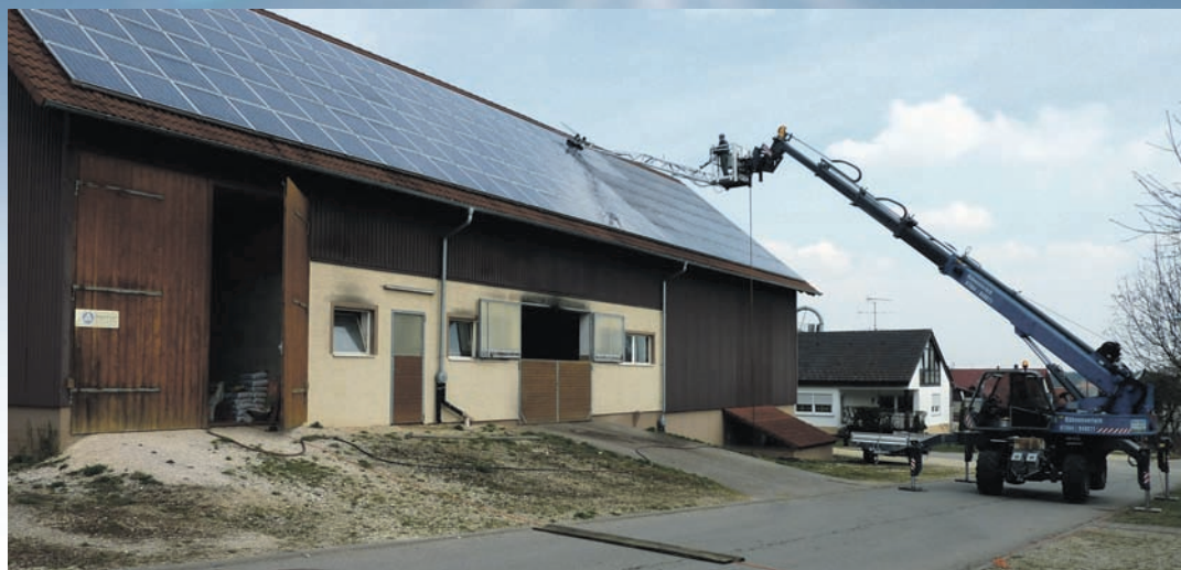
Durch den Einsatz des modernen Teleskopladers wird das Betreten der Dachflächen vermieden.
