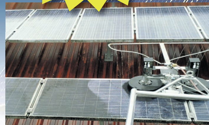
Gut erkennbar ist hier der Zustand vor und nach der Reinigung.
